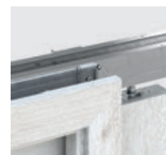
construcția casetei metalice
